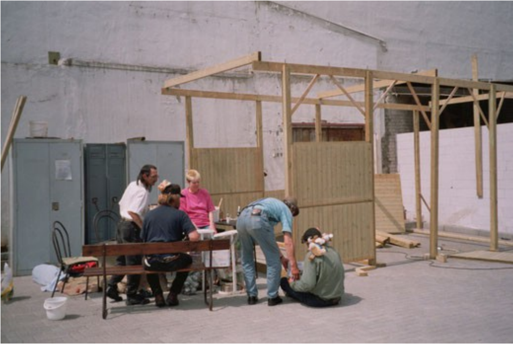
Die Trinkhalle wird gebaut
